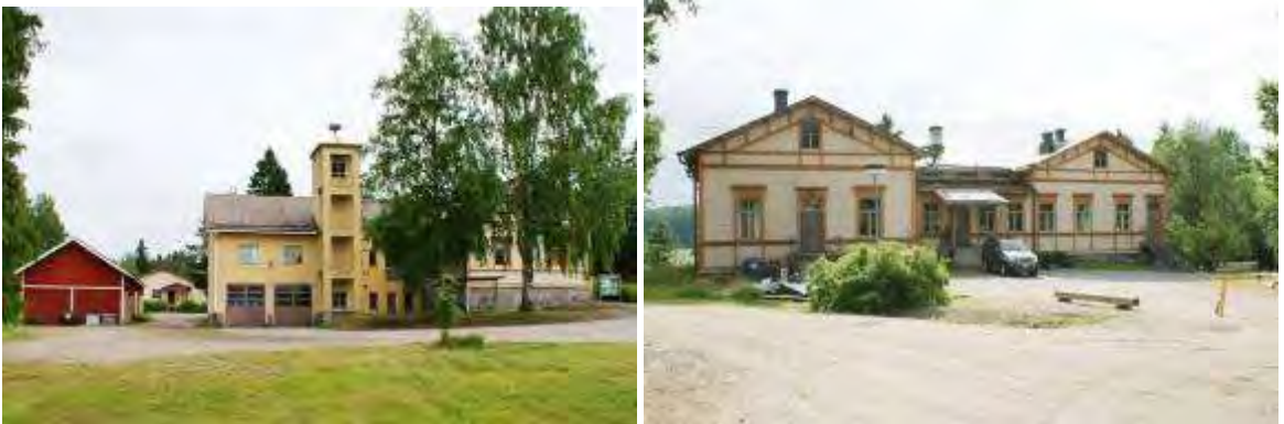
Kuva: Rapattu paloasema on vanhan kunnantalon (kunnantupa) jatkona, julkisivu kirkonaukion suuntaan.
