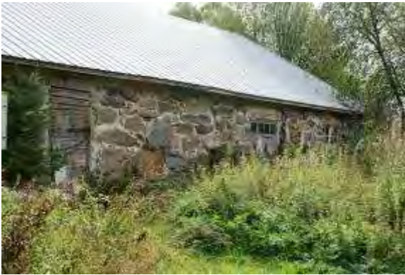
Kuva: Rautialan epäsäännöllisen muotoisista lohkokivistä muurattu suuri kavinavetta.
