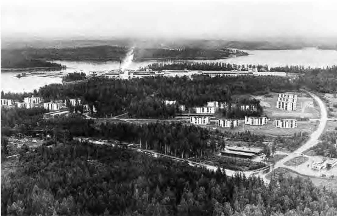
Kuva: Pellos Oy:n tehdas- ja asuntoalueet (vasemmalta oikealle I-IV) 1970-luvun puolivälissä. Etualalla ostoskeskus ja huoltamo. / Ristiinan kunta.
