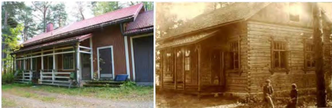
Kuva 28 Entinen meijerirakennus peruskorjattuna asunto- ja varastokäyttöön 1940-luvun lopulla. Vasemalla Ristiinan osuusmeijeri 1910-luvun alussa. (kuvat: Kulttuuriselvitystyö Ahola)
