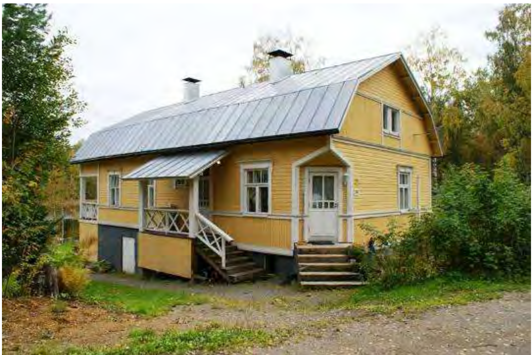
Kuva: Luhtarannan vanha kauppatalo.
