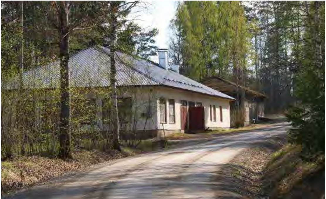
Kuva: Sahan alueella, vanhan portin paikan lähellä, on ryhmä 1950-luvun rakennuksia. Kuvassa on verstaas-, paja- ja asuntopuoltotilat sekä asunnon käsittänyt rapattu rakennus sekä lautaseinäinen tarvikevarasto. Niiden taakse jää uudempi kaksikerroksinen rapattu konttorirakennus, jonka, mahdollisesti myös verstaan, suunnitteli mikkeliiläinen arkkitehti Eero Jokilehto.
