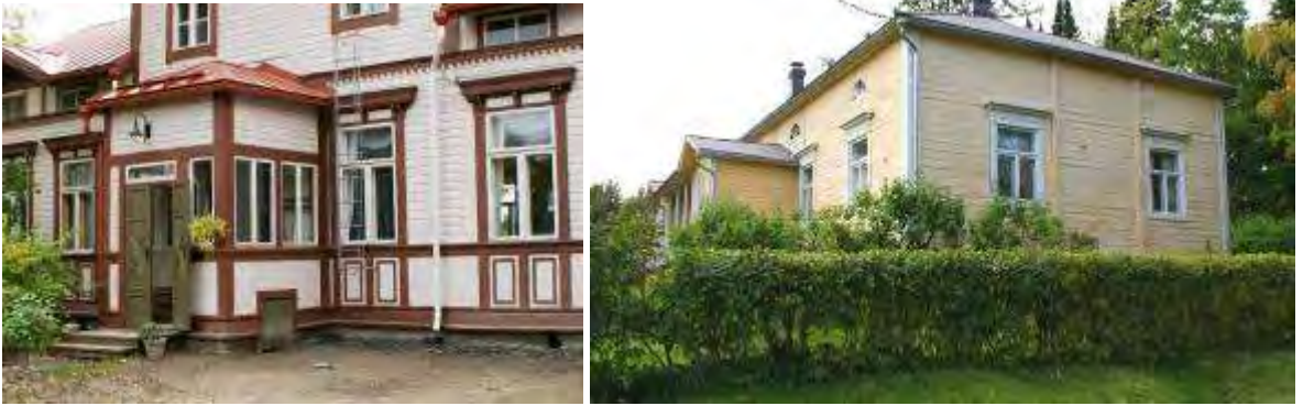
Kuva: Löydön kartanon päärakennus. Talo sijaitsee Löydönlammen ja vanhan Lappeentien tuntumassa.
